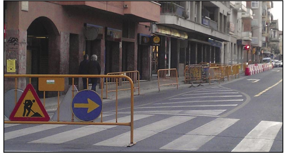
L'avinguda Francesc Macià, en obres
